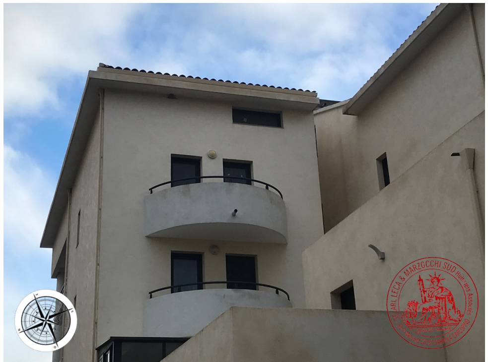
46. Vue supérieure de façade Ouest
